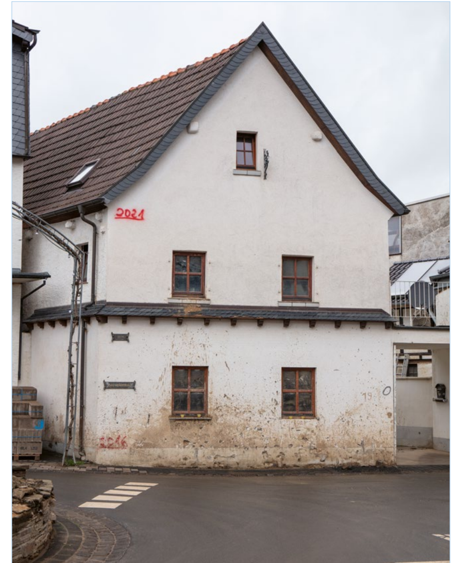
Hochwassermarken an einem zentral gelegenen Gebäude in Dernau zeigen die Fluten von 2016, 1910, 1804 und 2021 (von unten nach oben). Michael Szönyi, 5.4.2022.
