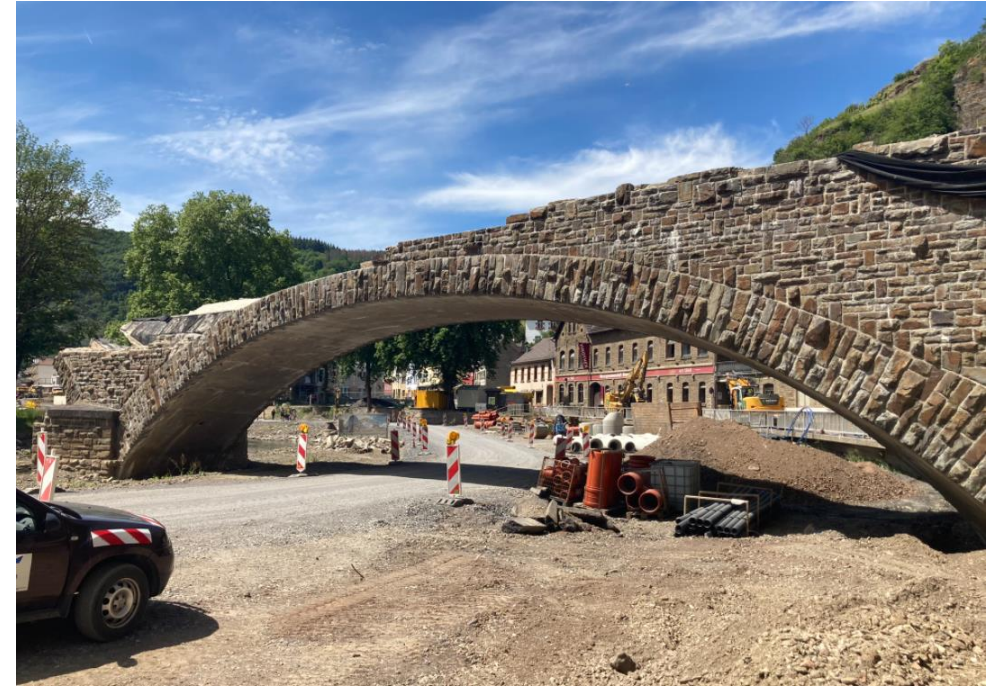
Das Bauwerk im Zuge des früheren Ahrradweges steht unter Denkmalschutz Antrag zum Abbruch ist gestellt – Ausgang noch offen !
