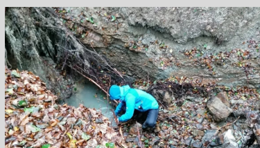
Abb. 6: Massive Tiefenerosion (> 1 m) im anschließendem Kerbtälchen (L: 677 m; H: 485 m)
